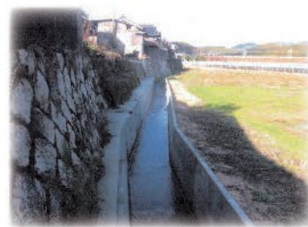
水路の改修整備(稻古屋)
